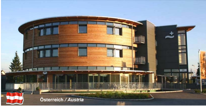
Bürogebäude / office building in Stadl Paura Architekten Frohnwieser, Böhm
